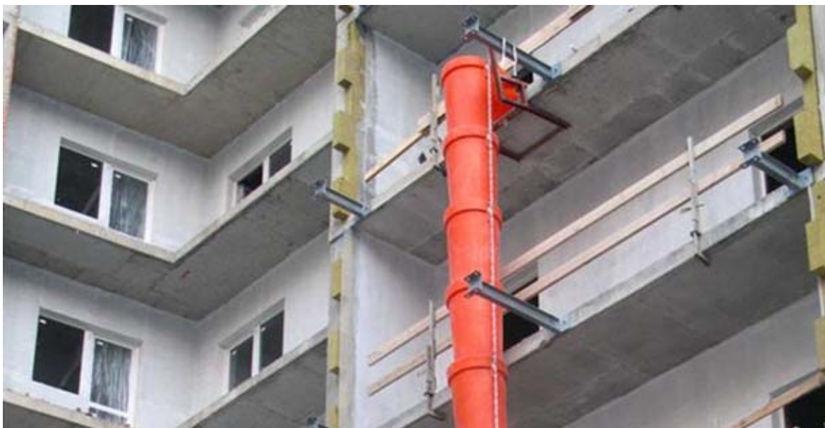
Рис.2. Строительный мусоропровод представляет собой универсальную систему для удаления сыпучего строительного мусора с этажей строящихся, ремонтирующихся и реконструируемых зданий и сооружений
